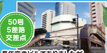
長年空きビルでありましたが 現在、高齢者向けマンションを建設中
