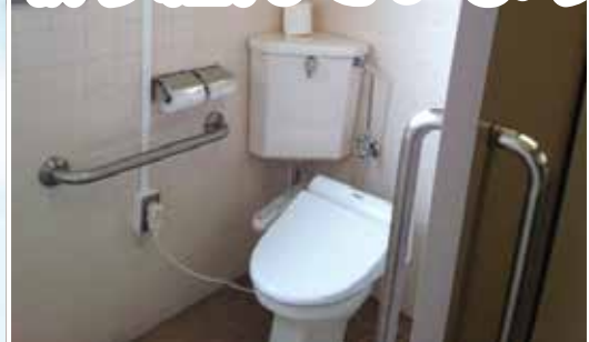
第五コミュニティセンターに 多機能トイレが 設置されました!
